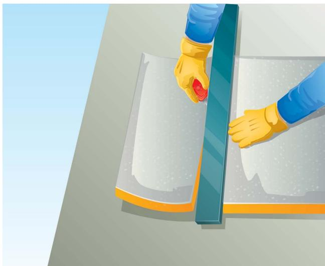
O material pode ser cortado com uma faca para dar dimensões exatas ou formas irregulares. Todos os tipos de suspensão mecânica com base em perfis visíveis sob a forma de “T” e os ângulos são fáceis de instalar.
